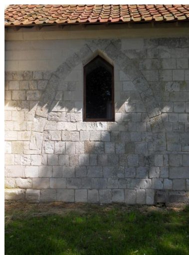
Première arcature mur sud. Phot. Isabelle Barbedor IVR22_20108010155NUCA
