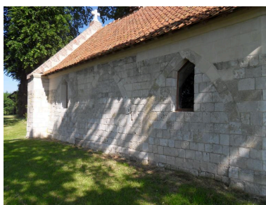
Mur sud. Phot. Isabelle Barbedor IVR22_20108010154NUCA
